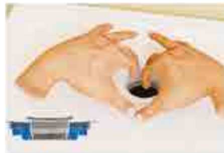
15. Az adapter-membrán gyűrűjét a leeresztőszelep alsó peremére pattintjuk. Ezzel megteremtettük a lefolyó és a tálca közötti tökéletesen tömített kapcsolatot. Tömítettségi próba szükséges!
