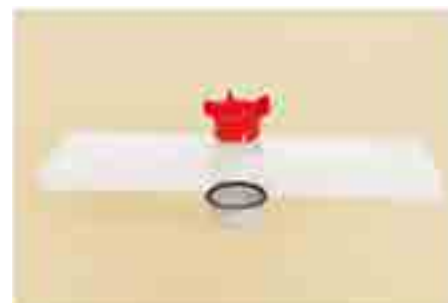
12. A zuhanytálcára a szerelőkulcs segítségével felszereljük a leeresztőszelepet és meghúzzuk olyan erővel, mely elegendő a tömítőgyűrű számára a tömítettség biztosításához
